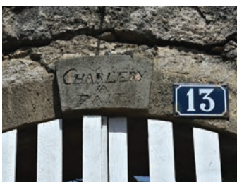
Détail du linteau de porte, n° 13 rue Émile-Zola
