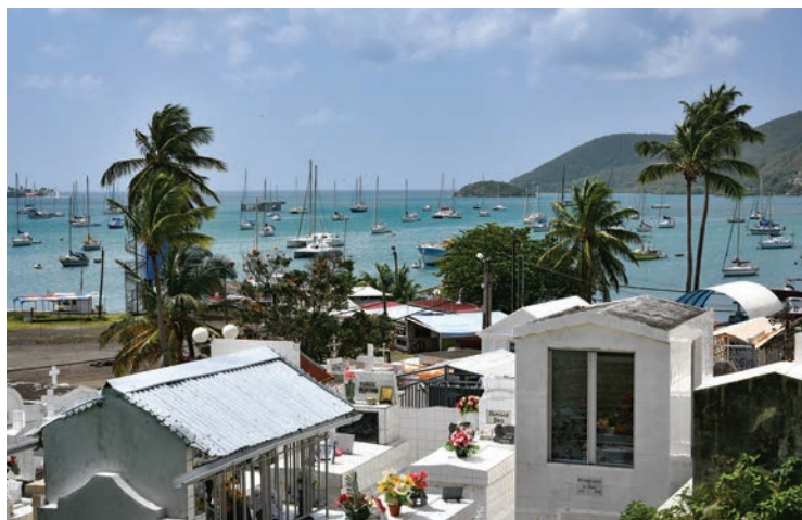
Vue d'ensemble du cimetière surplombant la baie
