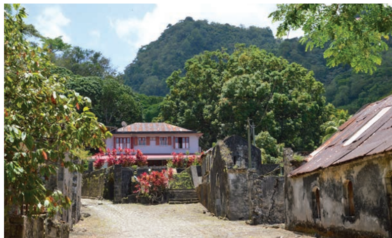
Une usine et des dépendances en ruine, petite cité fantôme sur laquelle veille la maison de maître.
