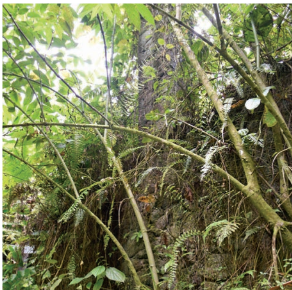
Les ruines de la distillerie Viviès, L'Ajoupa-Bouillon.
