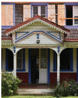
La façade principale, orientée au sud est, composée de sept travées, centrées sur un porche au fronton ouvragé.
