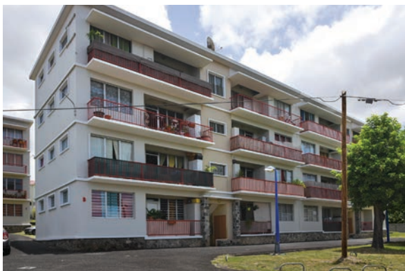
Immeuble HLM de la fin des années 1950, lotissement Saint-Georges
