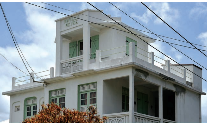
Façade principale, maison Thorel (1935), 36 avenue de la Batelière (10)
